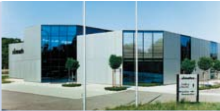
simatec ag, Wangen a. Aare, Switzerland
